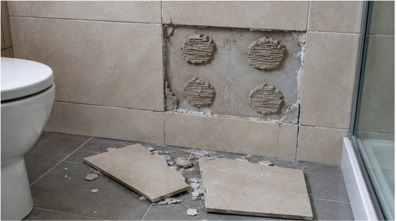
Punktverklebung. Vier Kleberkleckse statt vollflächigem Bett.
