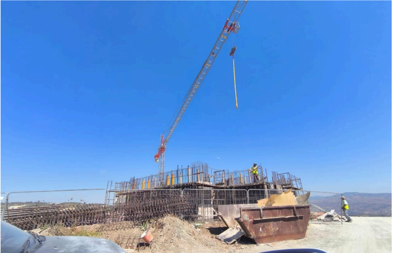
Rohbau im Bezirk Paphos. Die Bautätigkeit ist der Gegenspieler steigender Mieten. Eigene Aufnahme.
