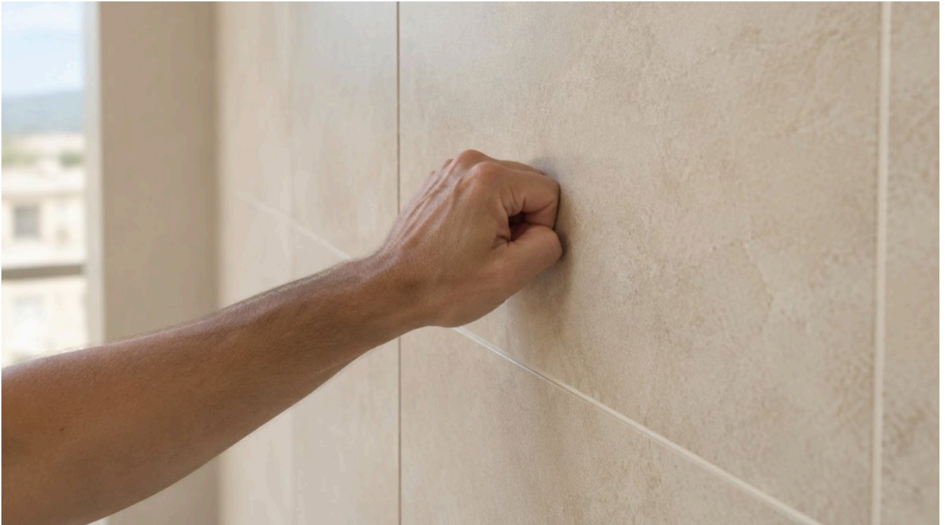
Fliesen abklopfen. Hohlklang heißt nicht vollflächig verklebt.
