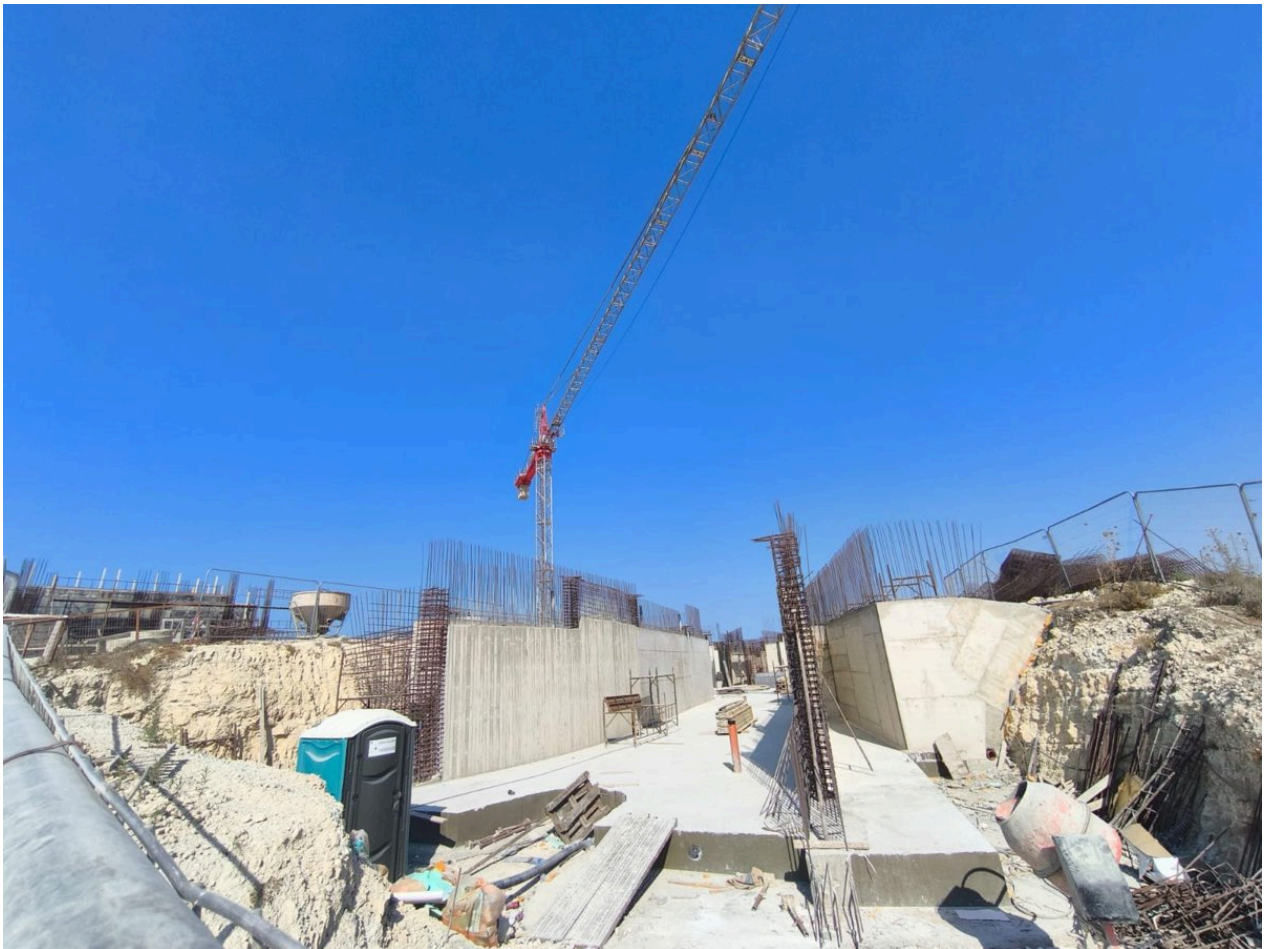
Baugrube mit Kellerwänden. In dieser Phase zahlst du beim Off-Plan-Kauf die ersten Raten. Eigene Aufnahme.
