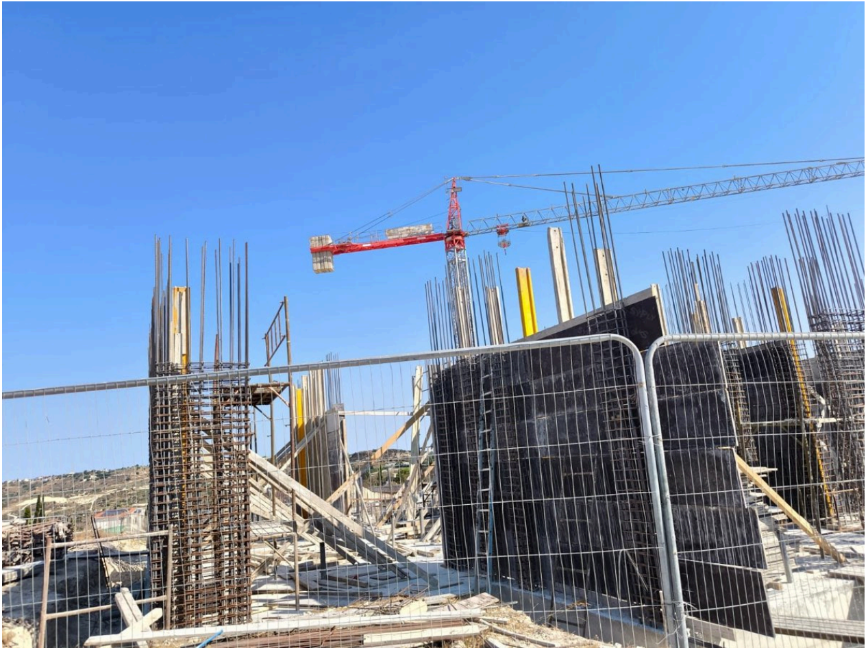
Schalung und Stützenbewehrung auf einer Baustelle in Paphos. Eigene Aufnahme.
