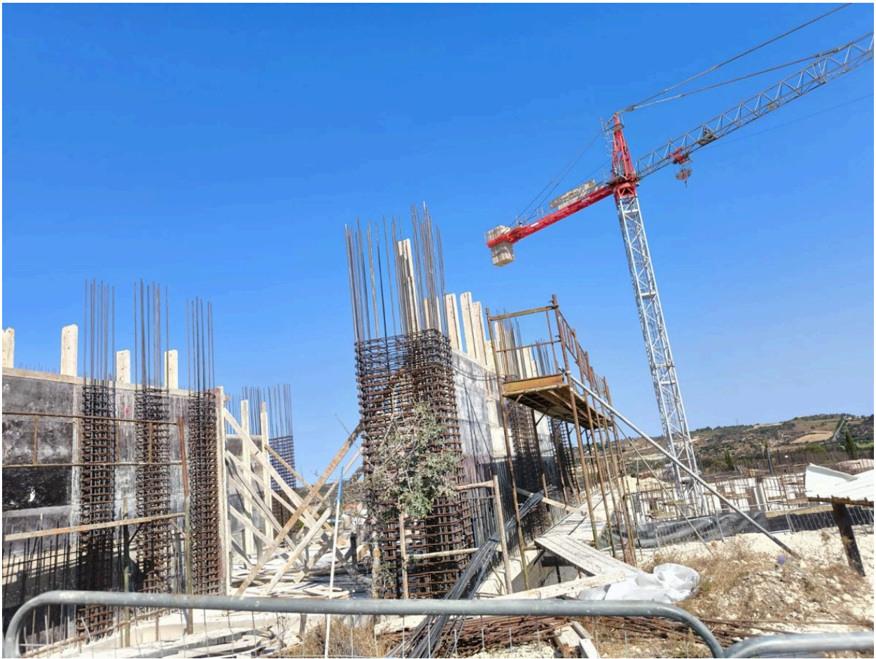
Bewehrung und Schalung im Rohbau. Was hier passiert, siehst du später nie wieder. Eigene Aufnahme.
