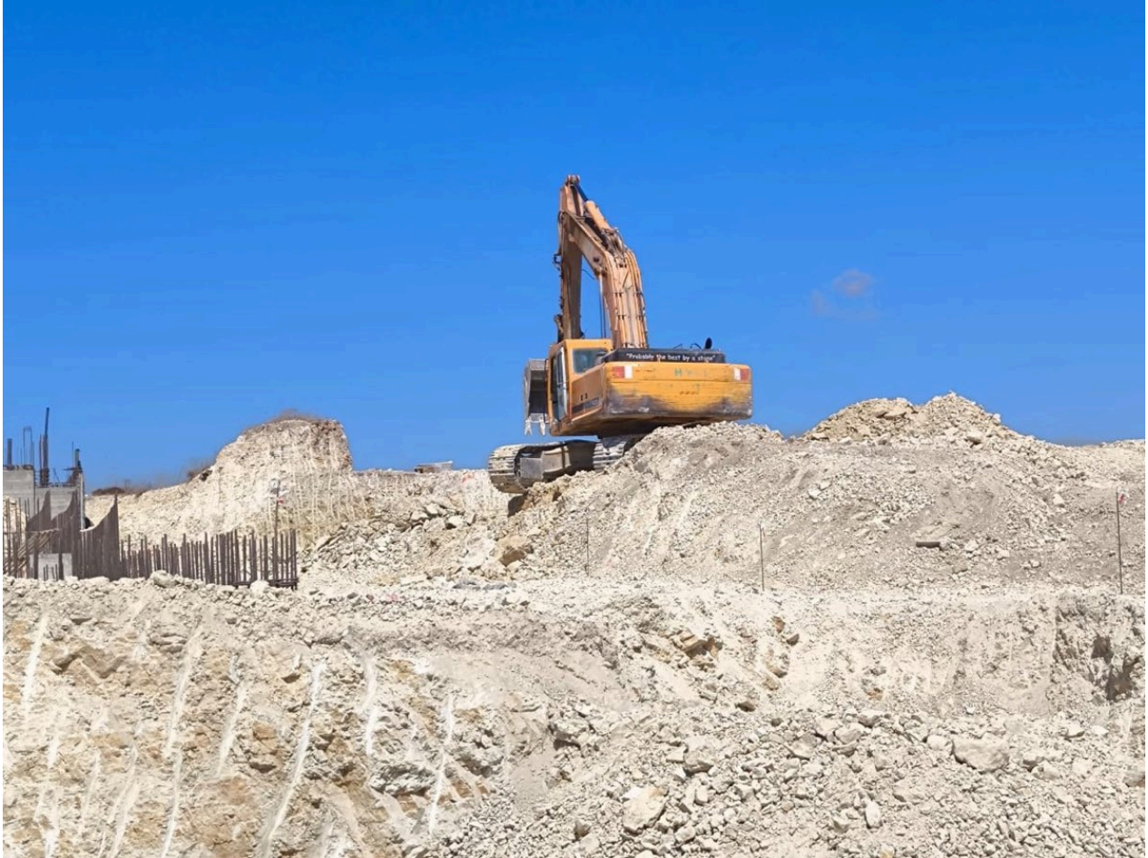
Aushub zum Baustart. Eigene Aufnahme.
