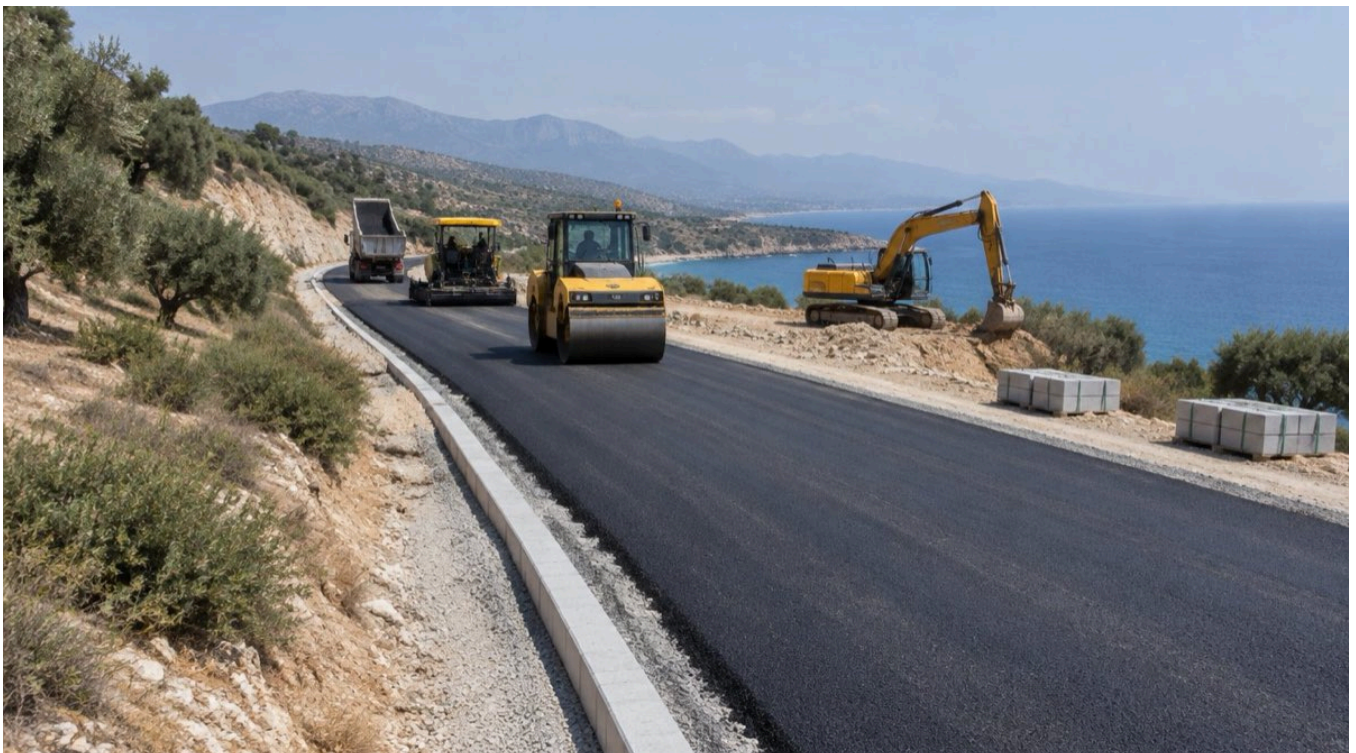
Straßenbau an einer Küstenumgehung.
